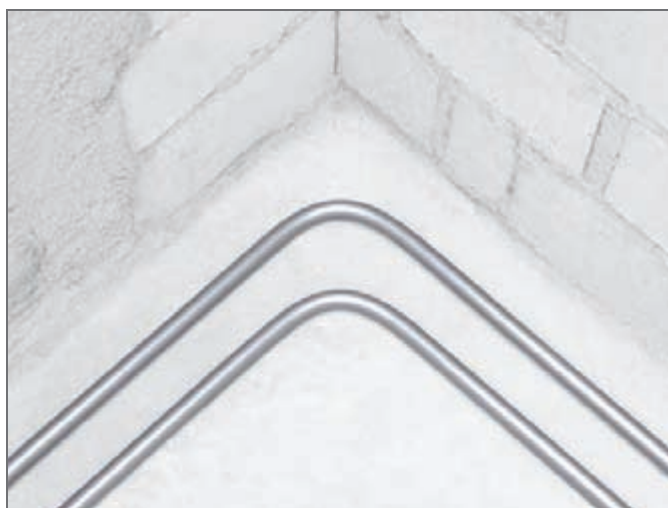
Rys. 13-1 Rura RAUTITAN stabil po zgięciu
